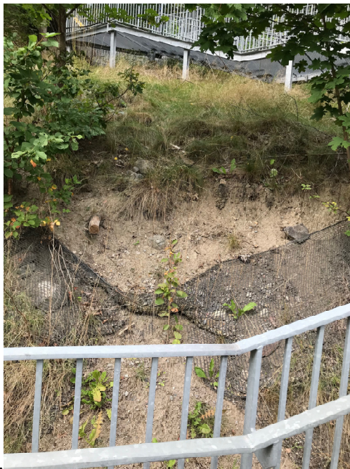
Figur 6 Befintliga erosionsförebyggande åtgärder i form av nät.
